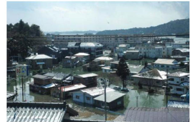
地盤沈下による浸水の様子
