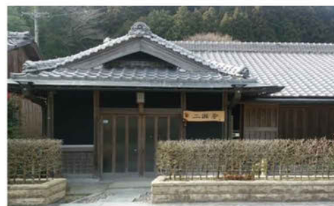
古民家を改修した民泊施設「二瀬屋」
