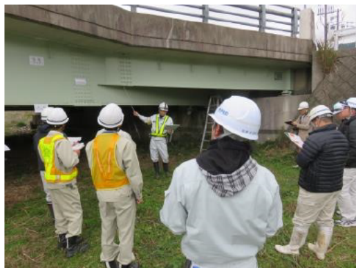
橋梁の各部材と 点検について説明
