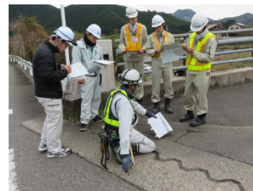
橋梁上面の点検
