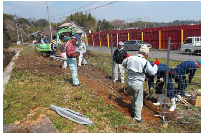
地域の皆さんで、サルなどの侵入を防ぐ防護柵を設置。
