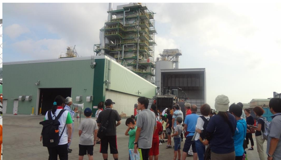
木質バイオマス発電 ((株)グリーンエナジー津)
