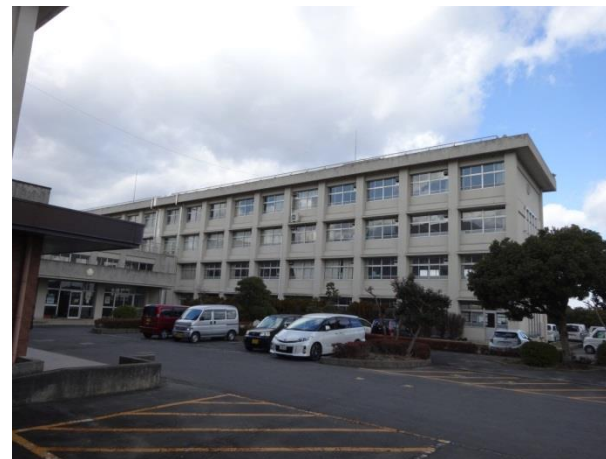
太陽光10kW 蓄電池15kWh
