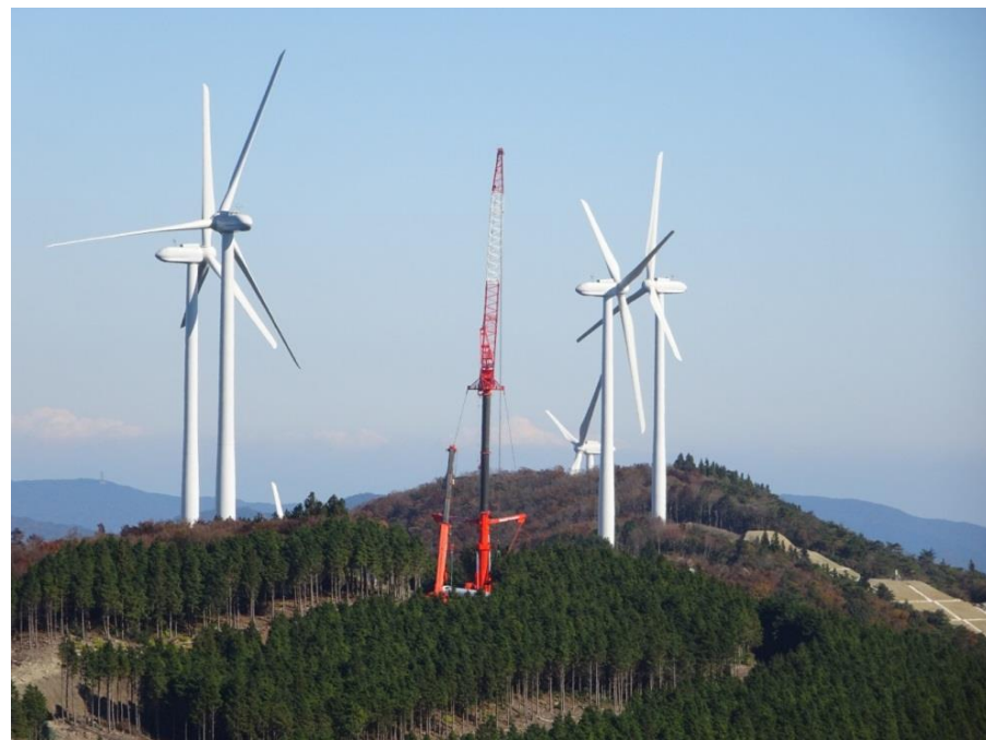
度会ウインドファーム建設の様子 写真提供:エコパワー(株)
