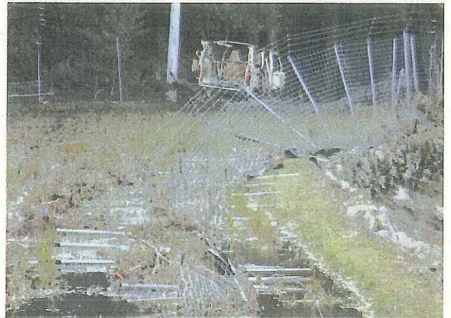
損壊した獣害防止柵（度会町）
