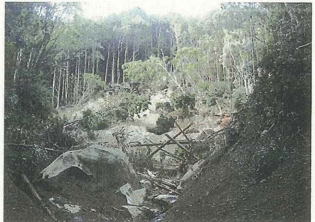
山腹の崩壊（御浜町）
