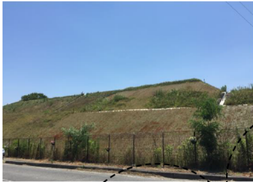
① 北側法面
