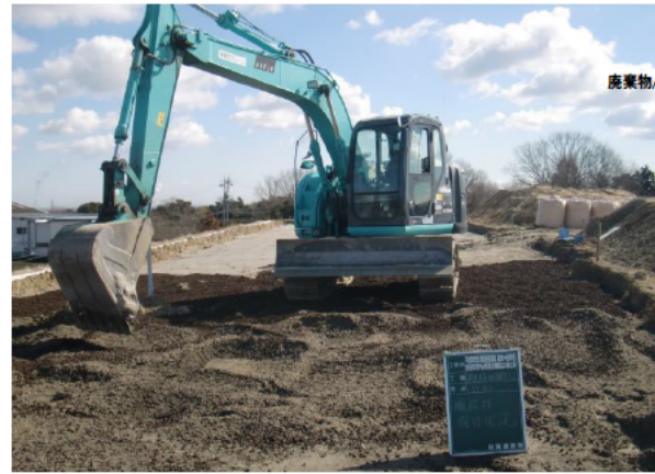
③ 天端部 硫化水素捕捉材施工状況
