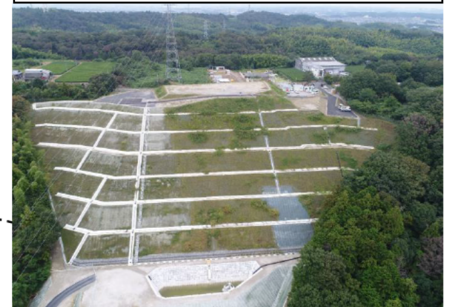
④ 南側法面
