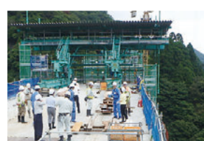
湯の山大橋(仮称)での調査
