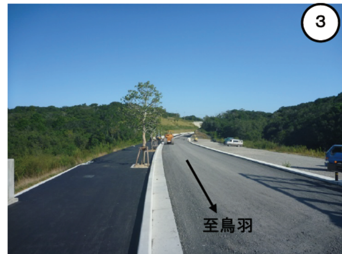
整備状況（近鉄跨線橋付近）
