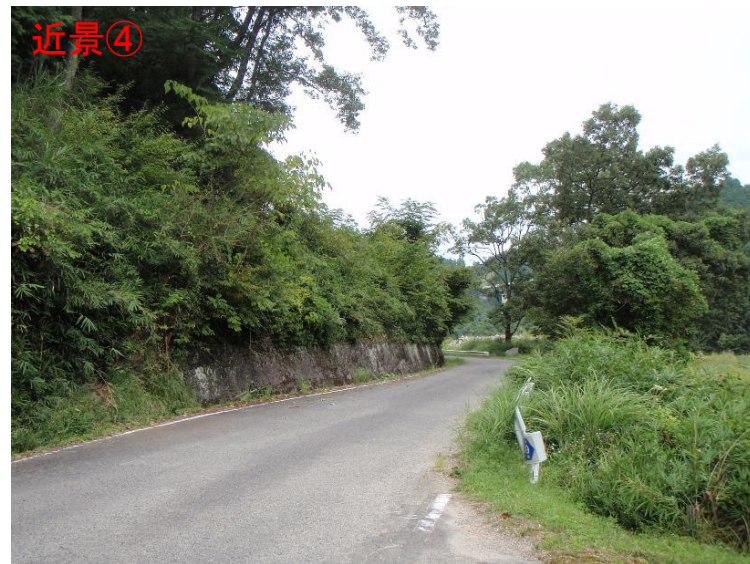
現道(字廣代付近)
