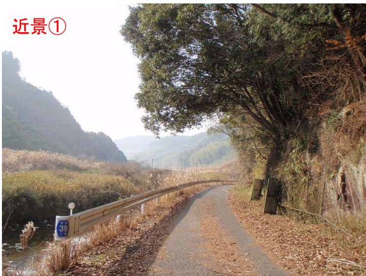
現道(西之沢橋上流付近)
