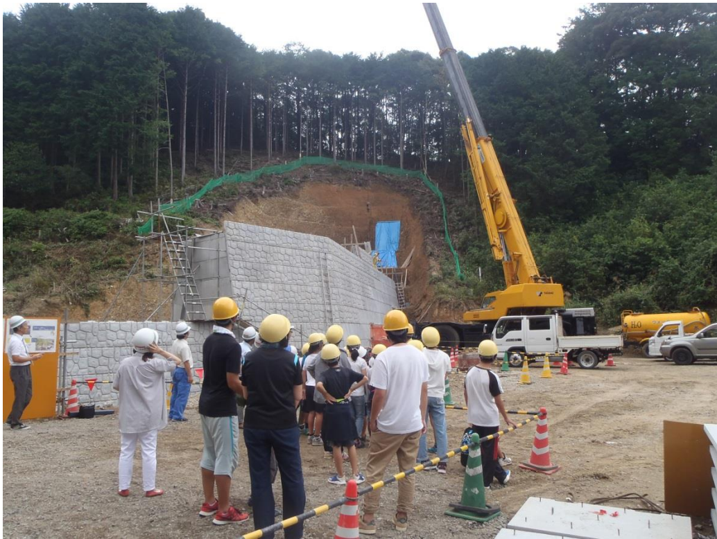
工事中の現場見学
