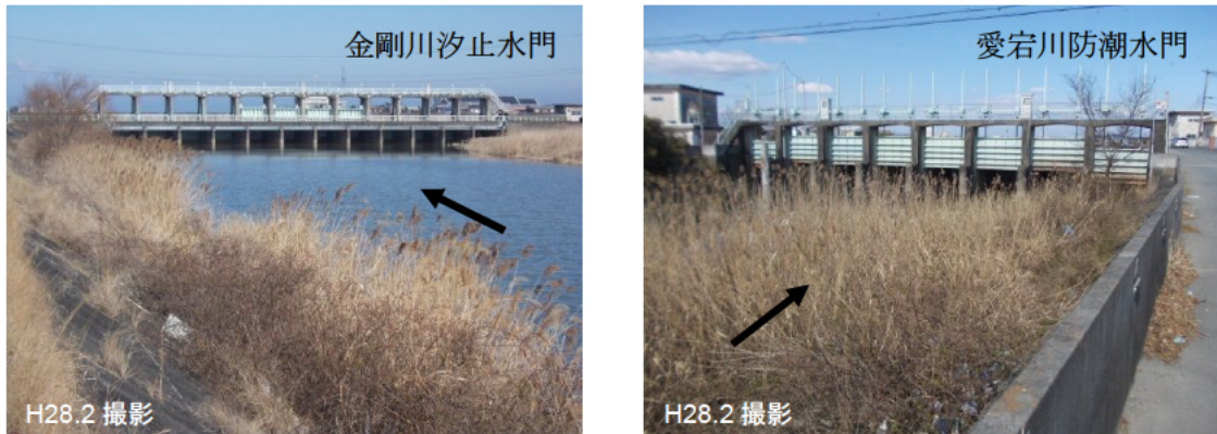
図 2.5 現在の防潮水門
