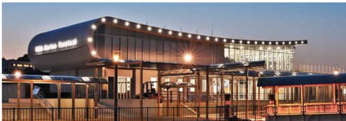
鳥羽マリンターミナル外観
