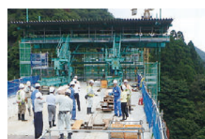
湯の山大橋(仮称)での調査
