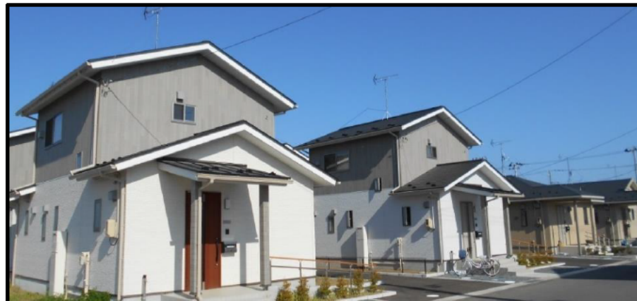
災害公営住宅(一戸建て)
