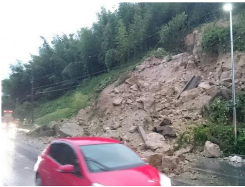
一般国道 421 号 被災状況
