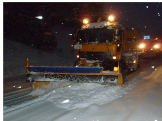
道路の除雪作業 (いなべ市)
