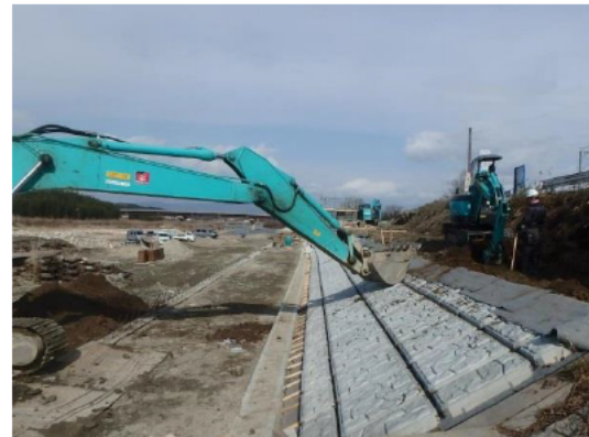
一級河川 木津川 (伊賀市)
