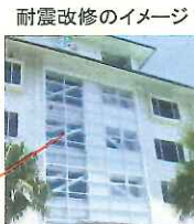
ブレース補強
