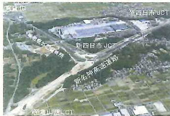
H30年度全線供用予定の新名神高速道路
