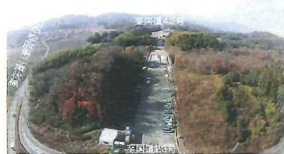
H29年度供用予定の国道42号松阪多気バイパス
