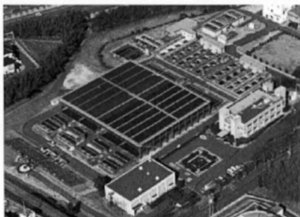
太陽光発電設備（播磨浄水場）
