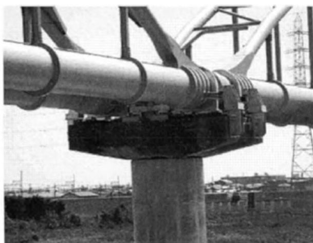
鈴鹿川第2水管橋の耐震化
