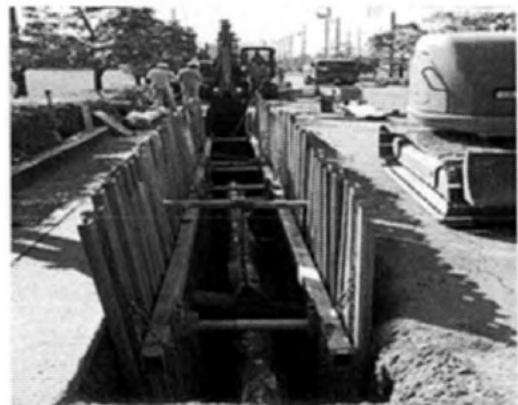
管路布設替えの状況
