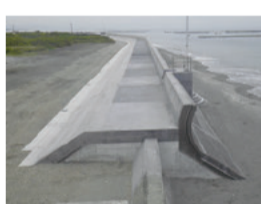
海岸堤防強化対策状況
