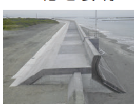
海岸堤防強化対策状況
