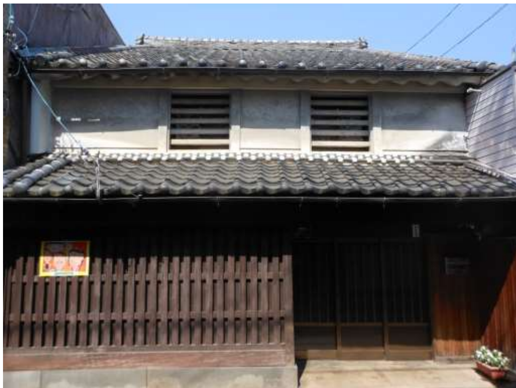
主屋東側外観
