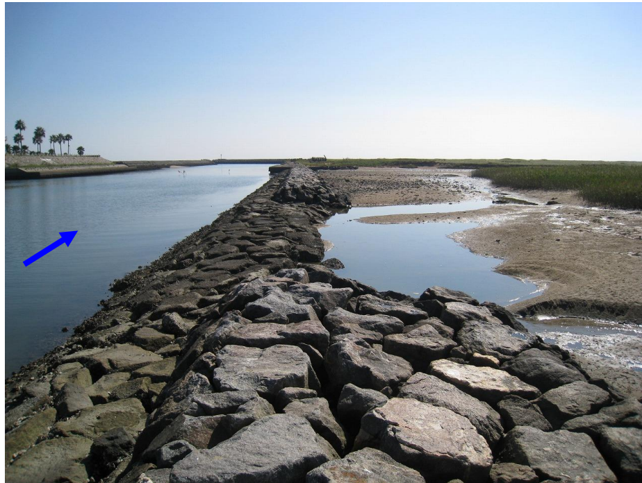
空石積による護岸整備
