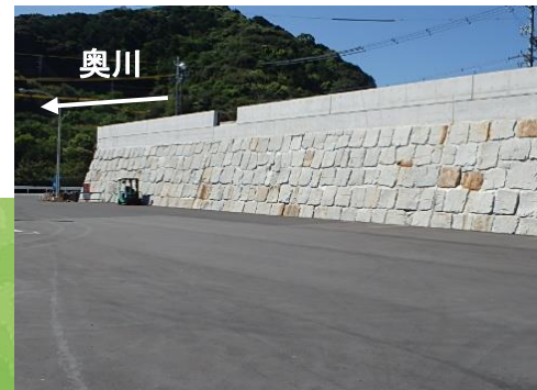
奥川河口防潮堤
