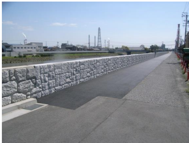
【堤防嵩上げ（特殊堤）】 （三滝川 四日市市北条町）
