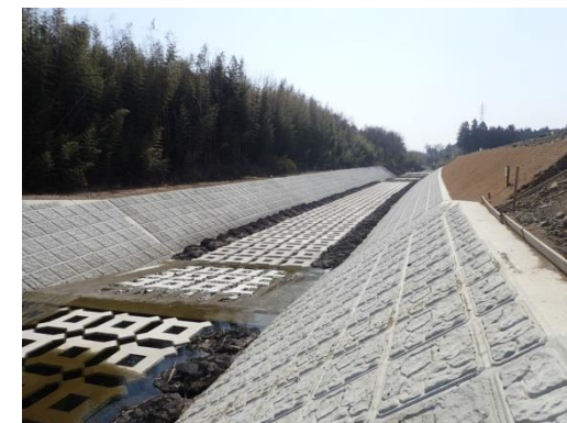
【災害改良復旧工事】 （内部川 四日市市和無田町）
