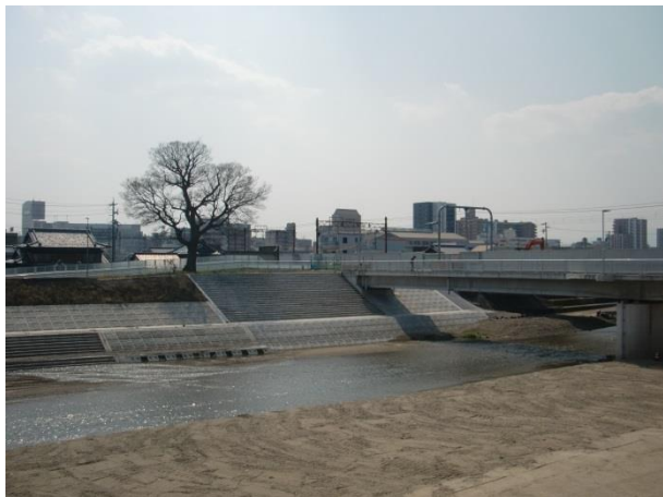
【河積確保（橋梁改築、護岸整備）】 （三滝川 四日市市西町）
