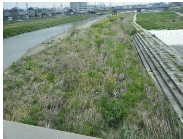
堆積土砂撤去 (三滝川、四日市市北町)
