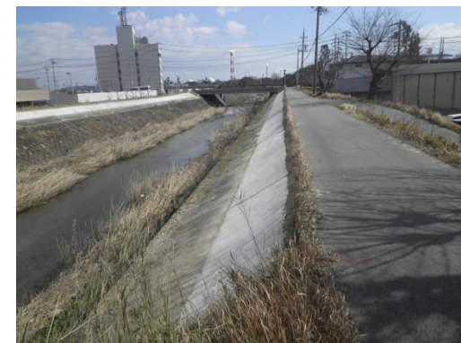
【護岸補強（張りコン）】 （鹿化川 四日市市日永1丁目）
