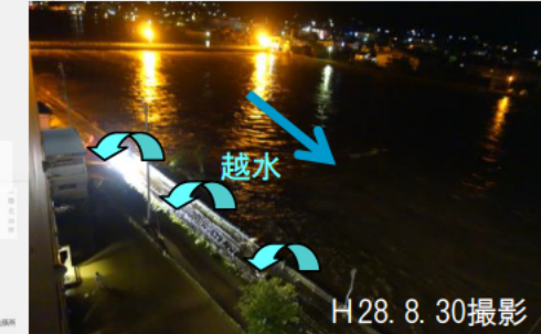
久慈川(右岸)越水状況
