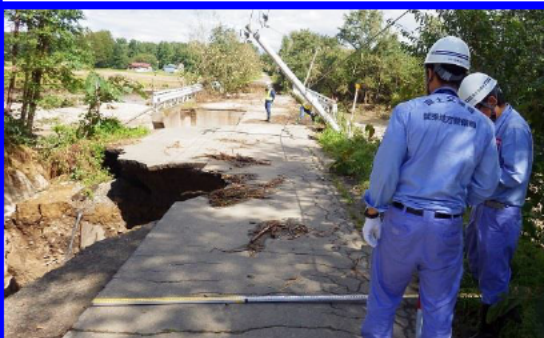
ベケレベツ川付近で流失した道路の被災状況を調査
