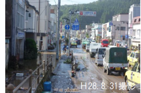
久慈市内 被害状況
