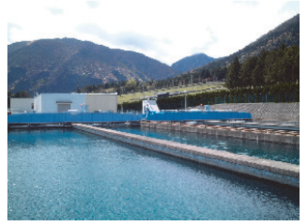
写真：北中勢水道 水沢浄水場
