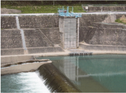
写真：南勢志摩水道 津留取水口
