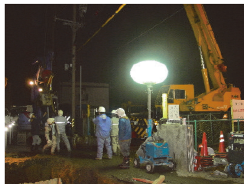
夜間の漏水復旧作業
