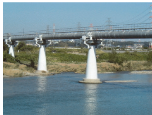
耐震補強後の水管橋
