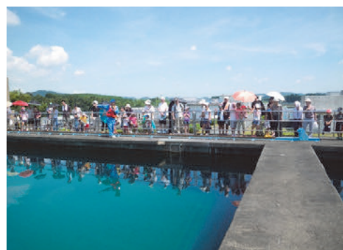
浄水場の施設見学
