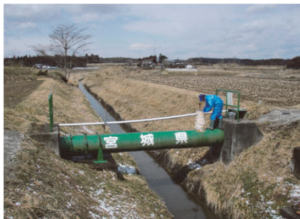
【水道施設・管路の点検(宮城県)】
