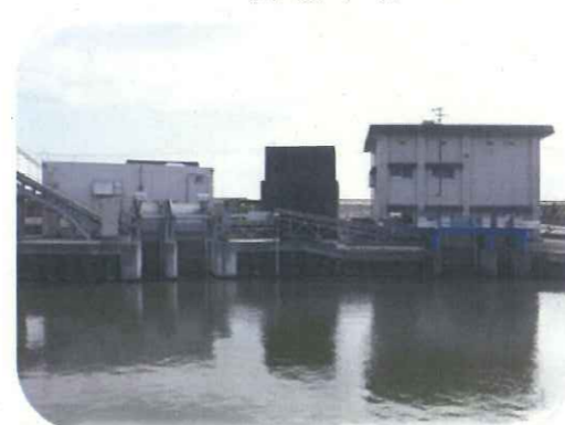
源緑輪中排水機場 (木曾岬町)
