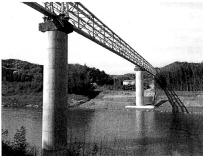
耐震補強工事の実施状況 [櫛田川水管橋下部工]
