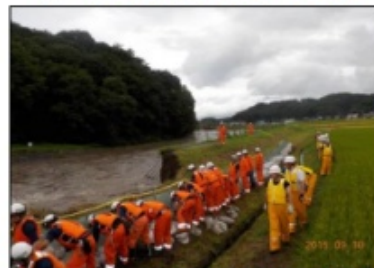
宇都宮市 田川左岸(関堀町地先) 改良積み土のう(土留鋼板使用)
