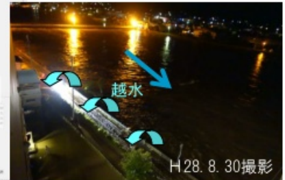
久慈川(右岸)越水状況
