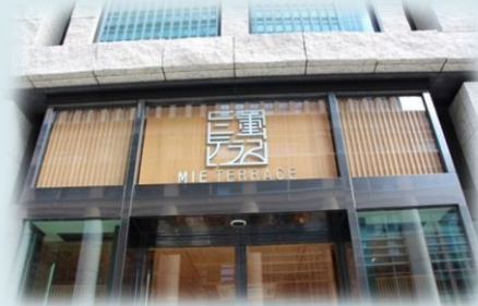
三重テラス 外観
