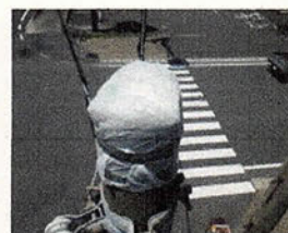
長寿命化補修をした信号柱頭頂部の劣化
