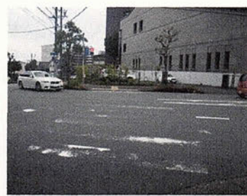
摩耗により機能が著しく低下した横断歩道（県庁西）
