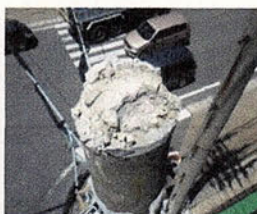
長寿命化補修をした信号柱頭頂部の劣化
