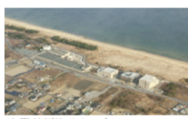
志登茂川浄化センター
