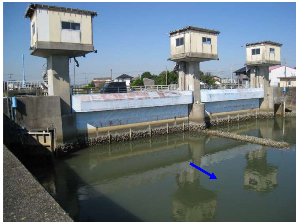
田中川防潮水門
