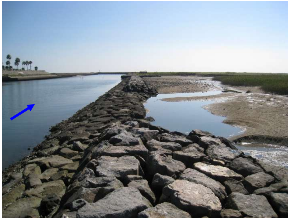
空石積による護岸整備
