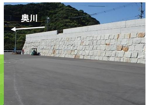
奥川河口防潮堤
