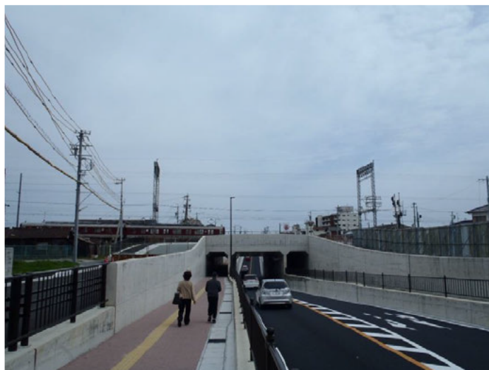
安全な通行空間が確保されています
