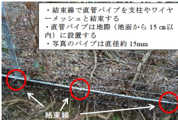
図3 直管パイプで下部を補強されたワイヤメッシュ柵の例
