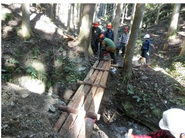
林業には必須の作業道を作る実習です。
