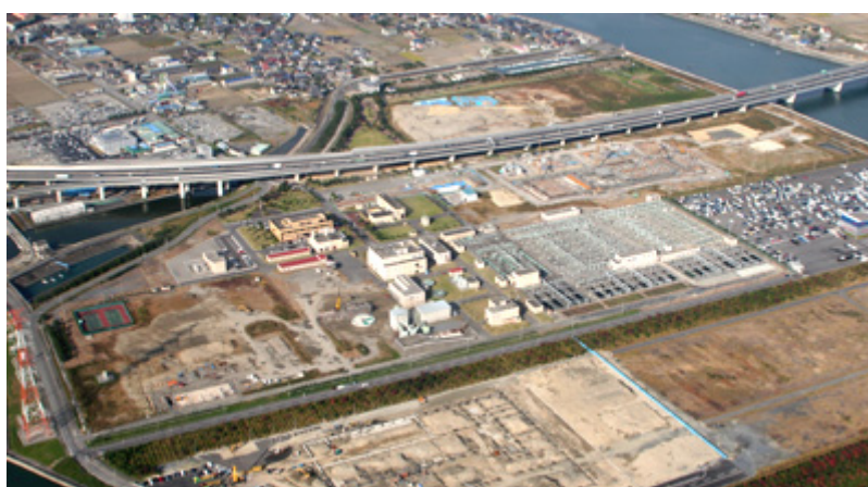
(北部浄化センター)
