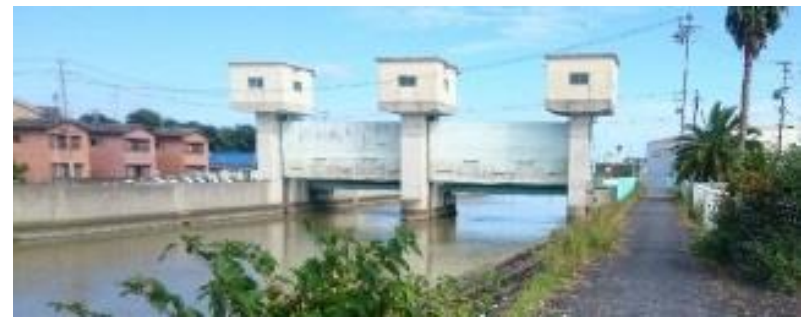
前川防潮水門(鵜方水門)：写真
