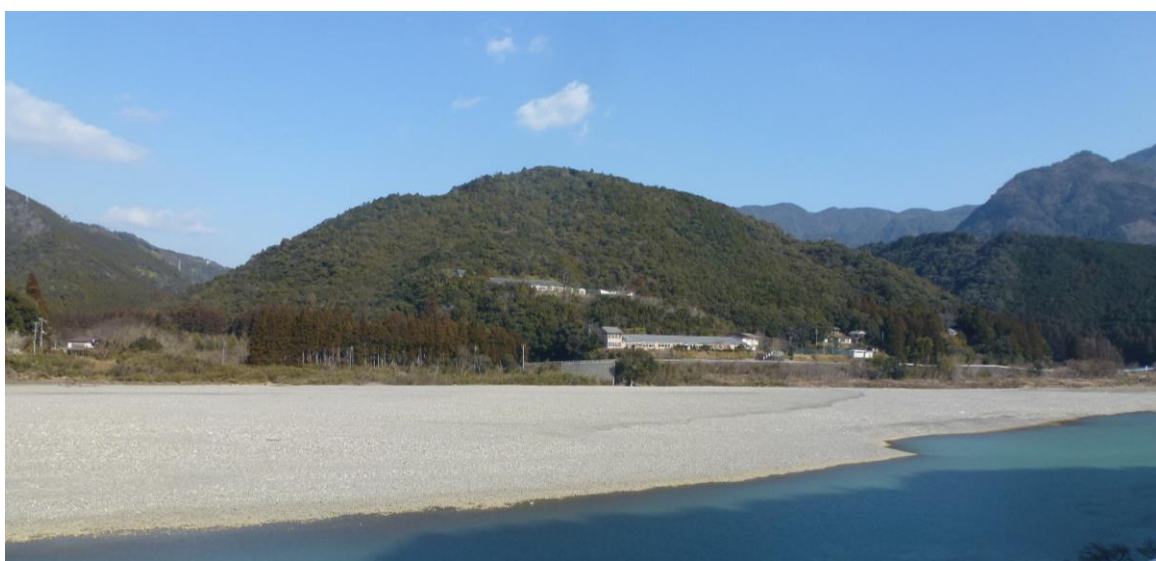
国道 168 号から左岸側（楊枝集落）への眺望
