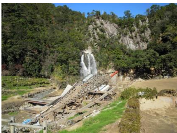
紀伊半島大水害により被災した 飛雪の滝キャンプ場（平成 23 年 12 月撮影）
