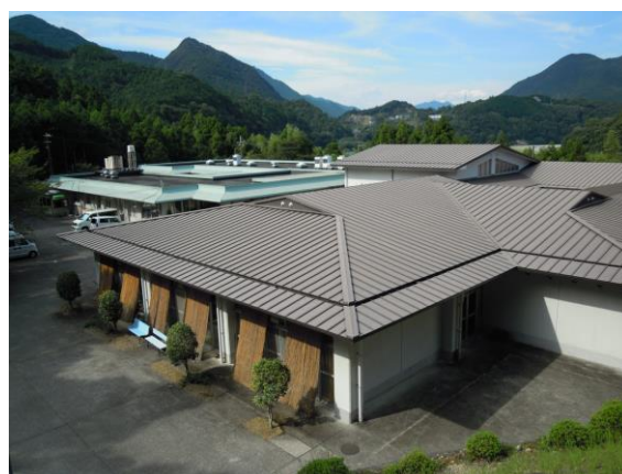
大規模な建築物（老人福祉施設）
