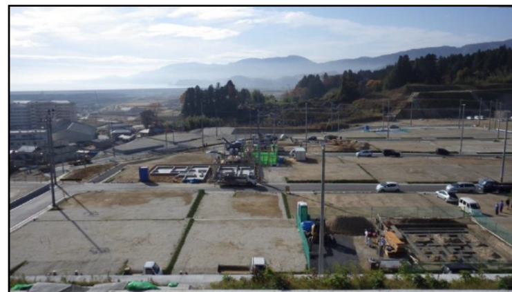
陸前高田市高台③工区 土地区画整理事業 H28年度完成
