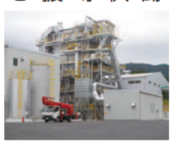
バイオマス発電所
