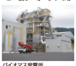
バイオマス発電所
