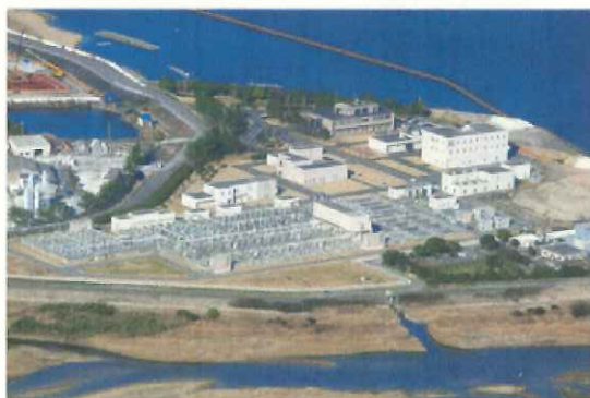
第2期整備事業が進んでいる南部浄化センター
