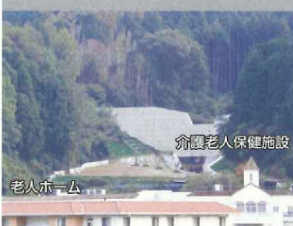
要配慮者利用施設を保全する砂防えん堤（山室 - 2、松阪市）
