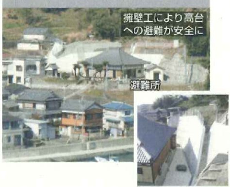
避難所を保全する急傾斜地崩壊防止施設（下津浦2地区、南伊勢町）
