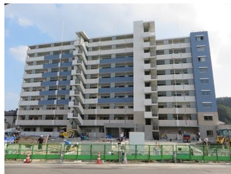
気仙沼市四反田地区災害公営住宅
