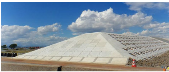
荒浜漁港 北堤防（第1線堤）（H26.12）
