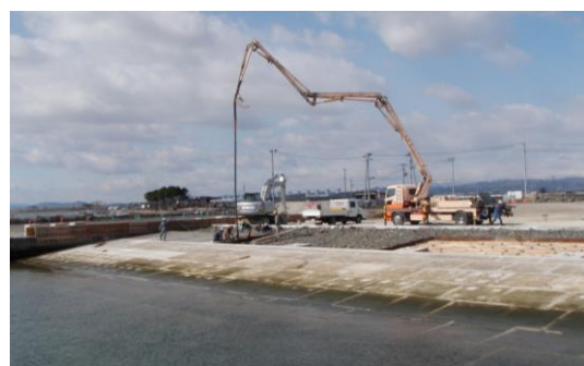
閑上漁港 船揚場 コンクリート打設 (H27.3)
