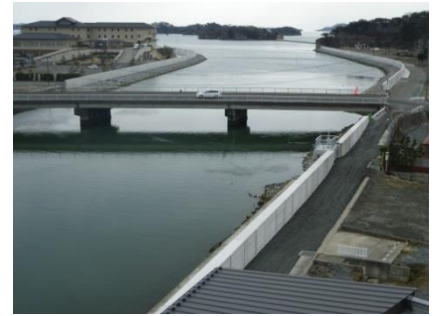
高城川完成状況(平成 28 年 3 月撮影)
