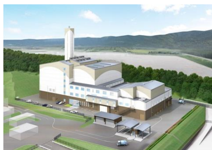
松阪市クリーンセンター 処理 200t/日（ストーカー式） 発電出力 3,500 kW
