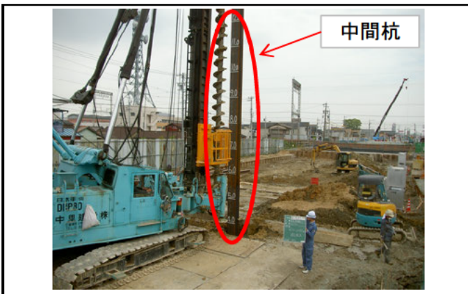
③中間杭打設
