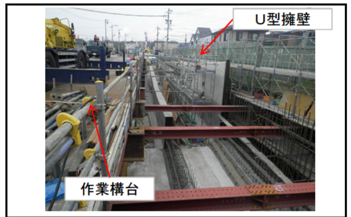
⑥U型擁壁コンクリート打設
