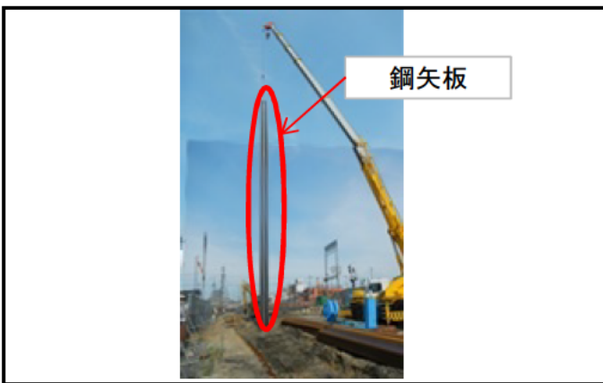
②鋼矢板打設
