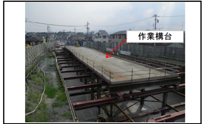
⑤作業構台設置
