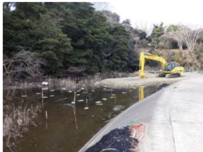
仮設道路設置状況
