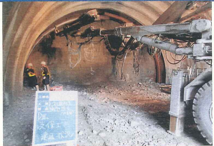
トンネル支保工(建込状況)
