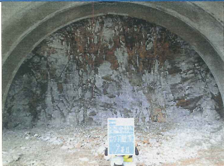
切羽(きりは)の状況
