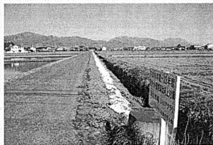
法面を利用したシバザクラの植栽
