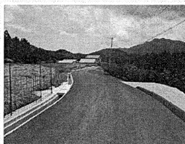
整備後の農業集落道
